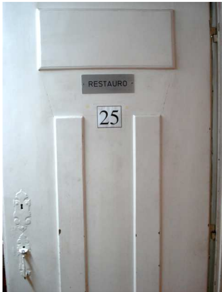
Figura 13: Porta de entrada para a sala do Restauro do MNT, fechada. Fonte: Foto-NC.
